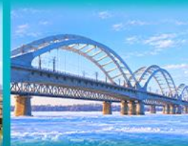
สะพานรถไฟพินโจว
