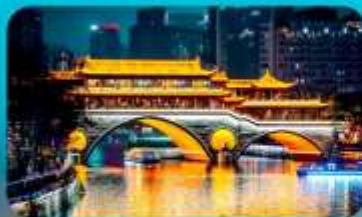
สะพานอันชุน
