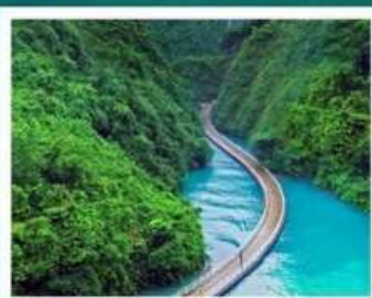
อัศจรรย์สะพานลอยน้ำ
